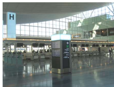
空港通信設備工事
